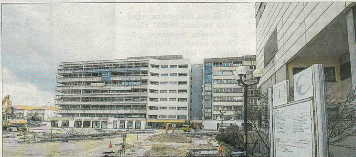
Les premiers locataires intégreront leur logement le 1 er juin. À l'extérieur, les travaux de terrassement sont en cours. De l'autre côté du bâtiment, un parc végétalisé doit encore être aménagé. Photo ER/Lionel VADAM
